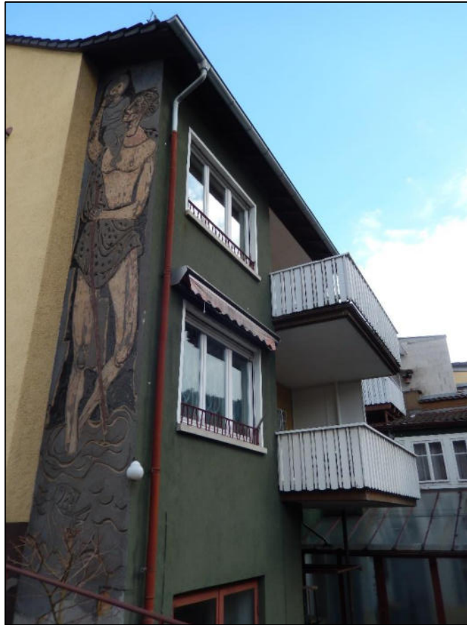
Foto 11: Fledermäuse beziehen gelegentlich auch Quartier in Markisenkästen oder unter Verblechungen, wie der den Balkon umfassenden Regenrinne.
