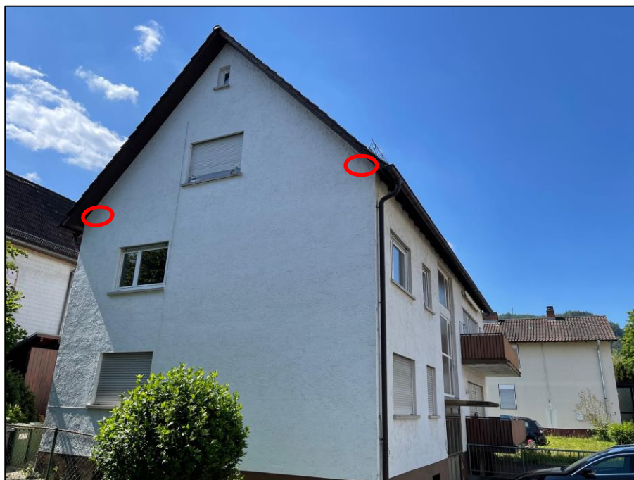
Foto 3: Mögliche Anbringungsorte für Mauerseglerkästen an der nordöstlich exponierten Giebelseite
