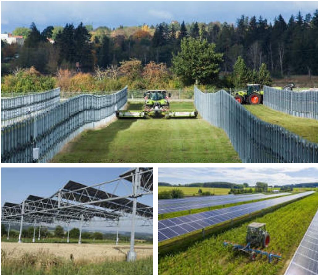
Abbildung 4-12: Beispiele für unterschiedliche Bauformen von Agri-PV Anlagen; oben: bodennahe Systeme, Bewirtschaftung zwischen den Agri-PV-Anlagen; unten links: hoch aufgestellte Systeme, Bewirtschaftung unter den Agri-PV-Anlagen; unten rechts: hoch aufgestellte Systeme, Bewirtschaftung zwischen den Agri-PV-Anlagen (Fraunhofer ISE, 2022)
