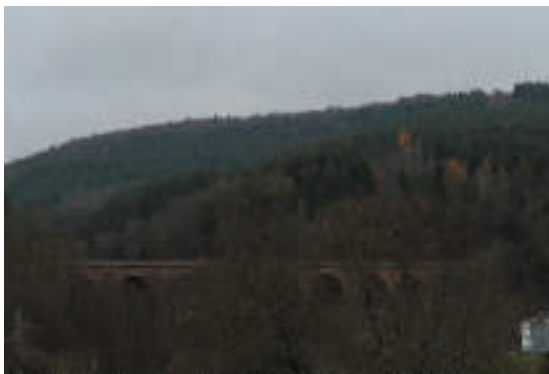
Abbildung 29: Hainbachtalviadukt (Quelle: WHS, 2019)
