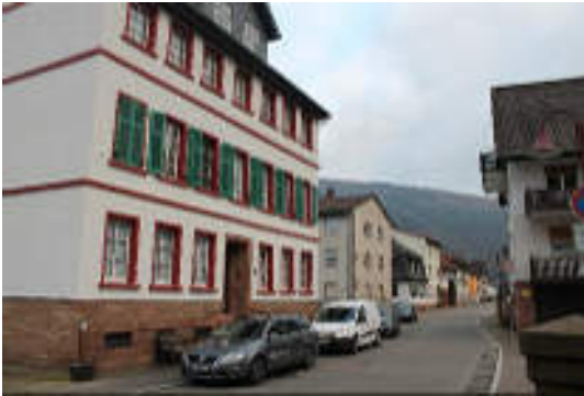
Abbildung 22: Ortsdurchfahrt (Quelle: WHS, 2019)
