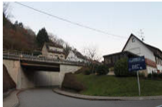
Abbildung 25: Bahnstufunterführung (Quelle: WHS, 2019)
