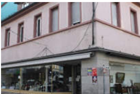
Abbildung 40: Modernisierungsbedarf in der Warenpräsentation und Außengestaltung
