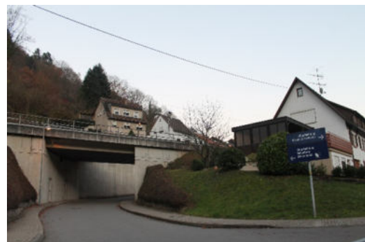
Abbildung 25: Bahnstufunterführung (Quelle: WHS, 2019)
