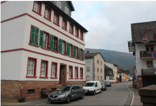
Abbildung 22: Ortsdurchfahrt (Quelle: WHS, 2019)
