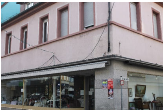
Abbildung 40: Modernisierungsbedarf in der Warenpräsentation und Außengestaltung
