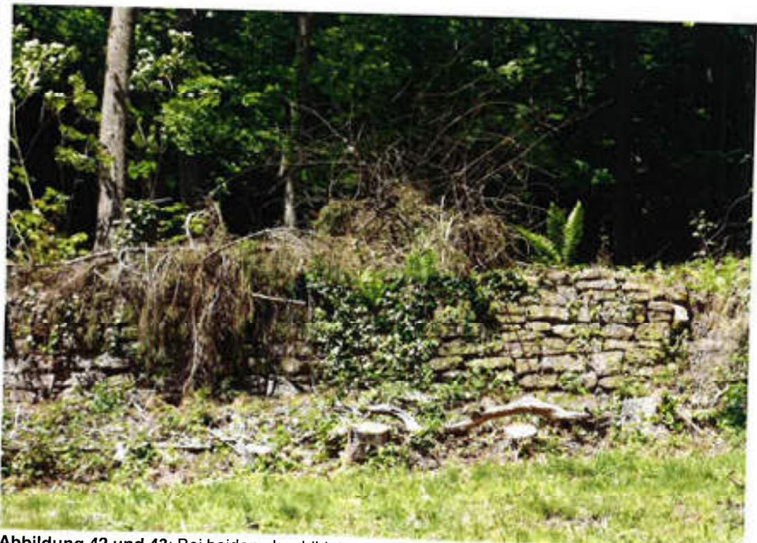
**Abbildung 42 und 43:** Bei beiden abgebildeten Trockenmauern sind wie auch bei vielen anderen Mauern des Gebietes Sanierungsmaßnahmen erforderlich. Der Bewuchs muss zurück geschnitten werden. Foto: 15.05.2019
