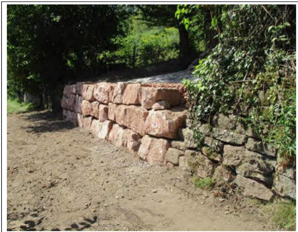
Abb. 28: Trockenmauersanierung mit Sandsteinquadern am Ohrsberg-Grundstück Flst.-Nr. 5599 entlang des Panorama-Rundwegs als Cef-Maßnahme für Eidechsen im Rahmen der Aufstellung des B-Plans „Wolfsacker“ (Foto: 29.08.2017); Kosten für 9,70 m Trockenmauer mit Hinterfüllung, Drainage und Mineralbetonfundament: € 6.960,-- (brutto)
