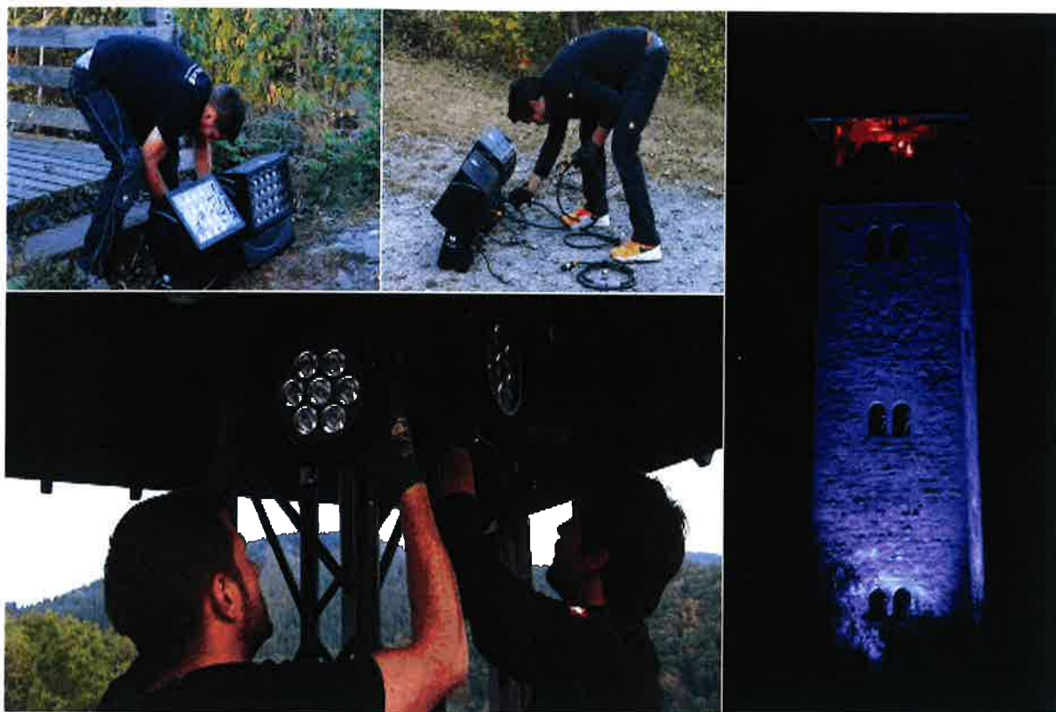
Abbildung 18: Installation der Beleuchtung des Ohrsbergturms im Oktober 2018, (RICHTER 2018)
