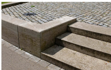
Blockstufen mit Mauer / Treppenanlage
